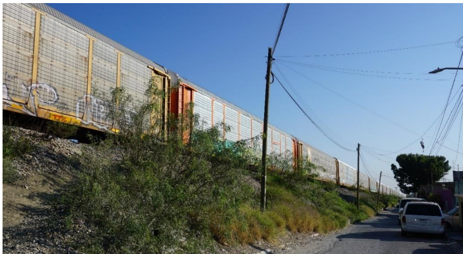
Figura 170 TRAMO ELEVADO DE LA VÍA DE TREN, SOBRE CALLE BORDO DEL FERROCARRIL
