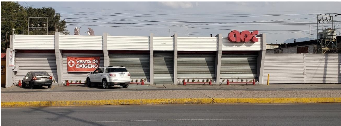
Figura 44 BODEGAS Y TALLERES
