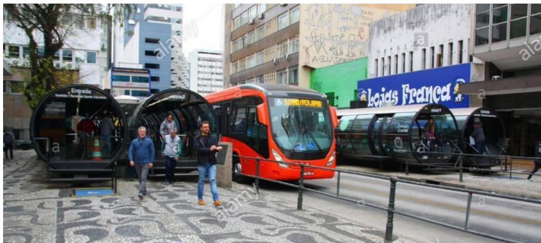
Figura 20 TERMINAL DE BRT EN CURITIBA, BRASIL
